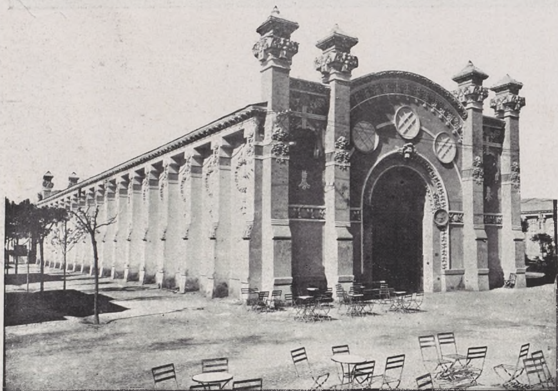
PABELLÓN DE MAQUINARIA
