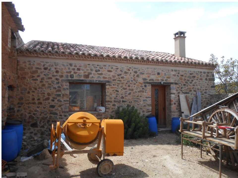
Fotografía 4. Fachada Oeste desde el patio interior
