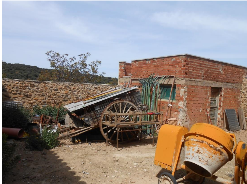
Fotografía 7. Fachada Norte desde el patio interior
