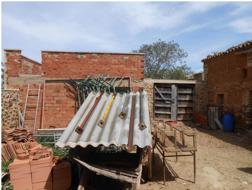
Fotografía 6. Fachada Este desde el patio interior
