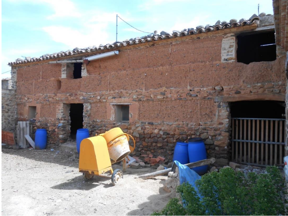
Fotografía 5. Fachada Sur desde el patio interior
