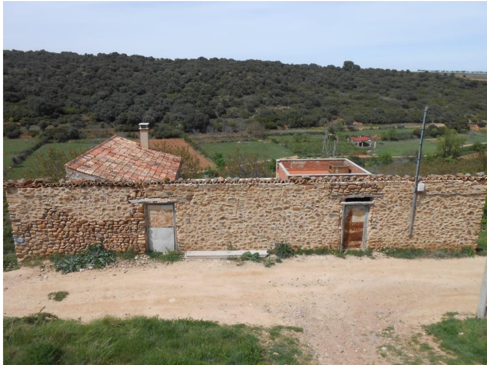
Fotografía 3. Fachada lateral desde el exterior (Fachada Sur)
