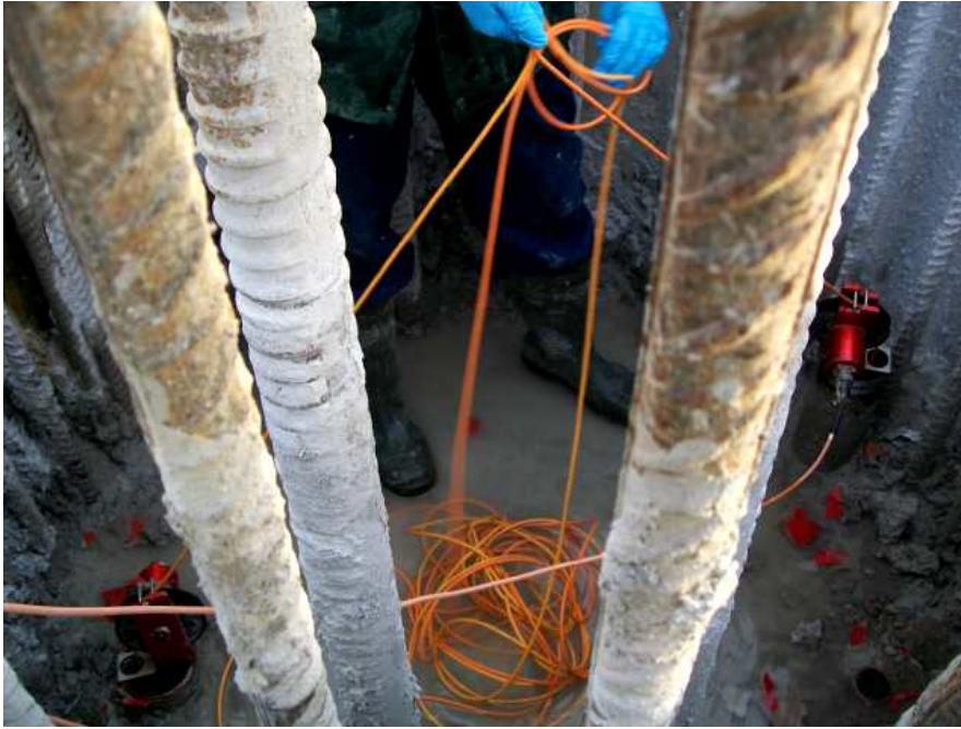
Ilustración 18. Ensayo Cross-Hole en pila
