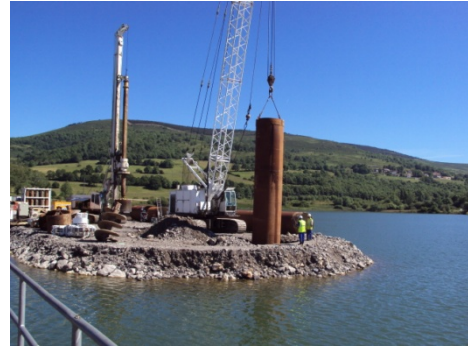
Ilustración 7. Posicionamiento e hincado de camisa pérdida en estribo E-1 ( Orzales )
