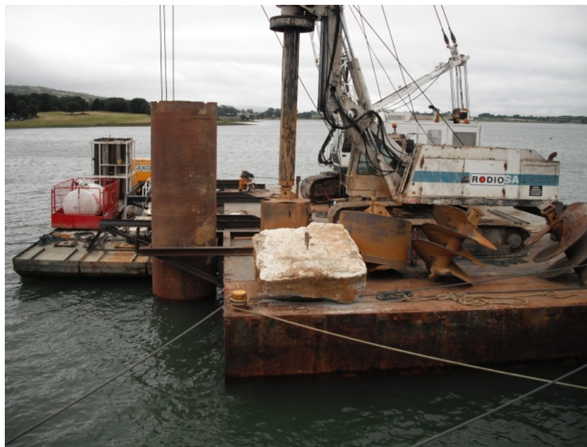
Ilustración 13. Trabajos desde pontona
