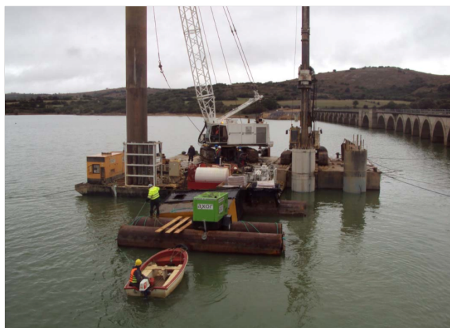
Ilustración 12. Ejecución de pilas-pilote desde pontona
