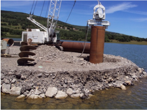
Ilustración 7. Posicionamiento e hincado de camisa pérdida en estribo E-1 ( Orzales )
