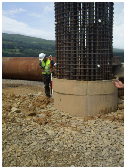
Ilustración 9. Colocación de la armadura en el interior de la excavación
