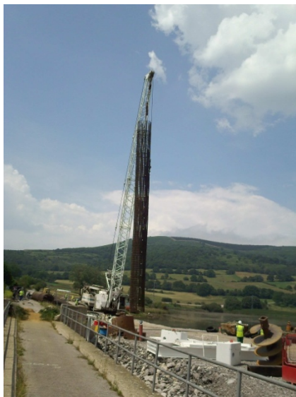
Ilustración 9. Colocación de la armadura en el interior de la excavación
