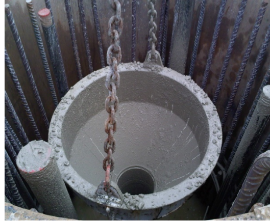
Ilustración 10. Introducción del tubo Tremie en el interior de la excavación
