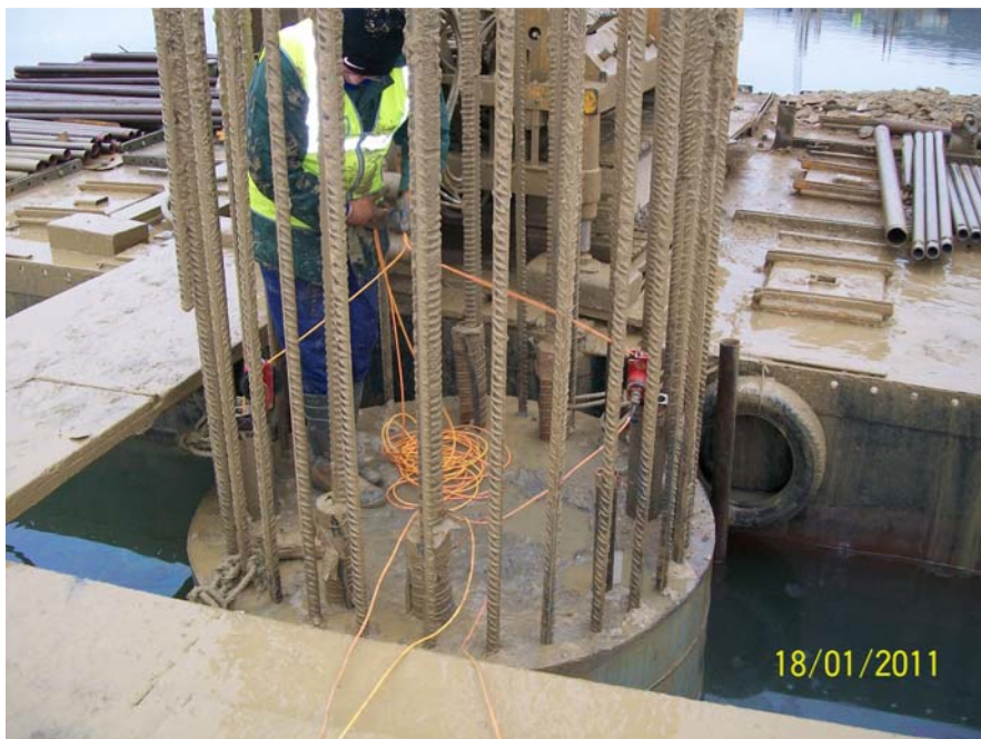
Ilustración 17. Ensayo Cross-Hole en pila
