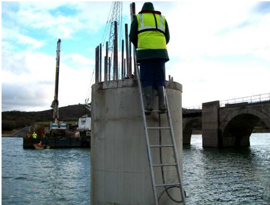
Ilustración 16. Ensayo Cross-Hole en pila
