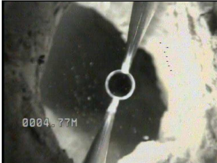
Ilustración 22. Vista interior del pilote izquierdo de la pila 6
