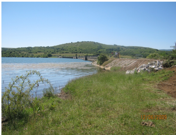
Ilustración 6. Vista del puente antiguo
