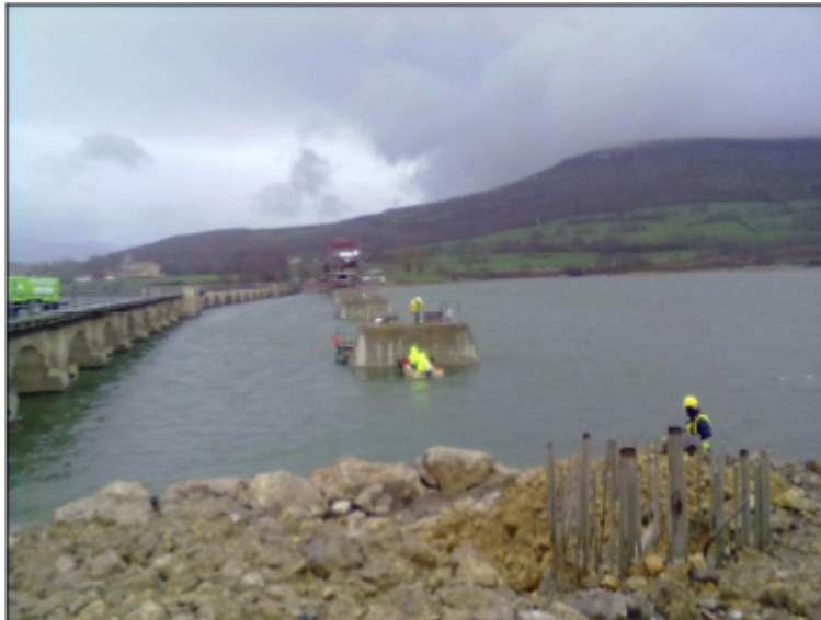
Ilustración 21. Posición de la pila 6 próxima al lado de La Lastra
