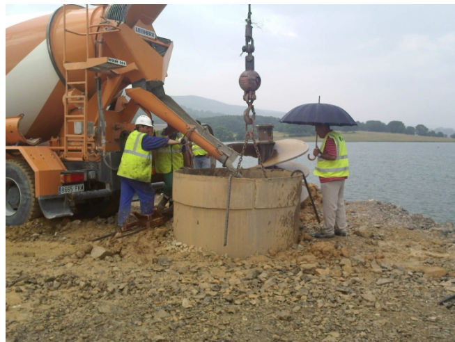
Ilustración 11. Hormigonado del pilote
