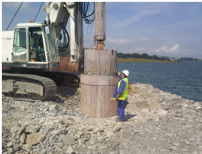
Ilustración 8. Excavación del pilote
