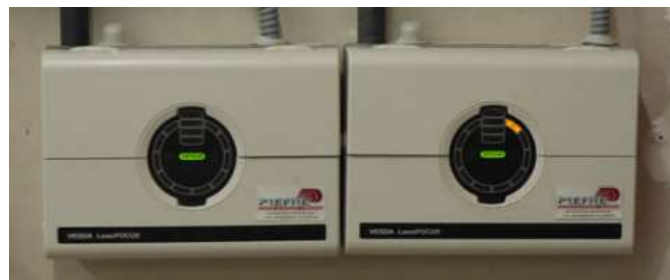
Ilustración 5- Detectores de humo por aspiración («Tipología de los detectores de incendios de incendios y gases», 2012)
