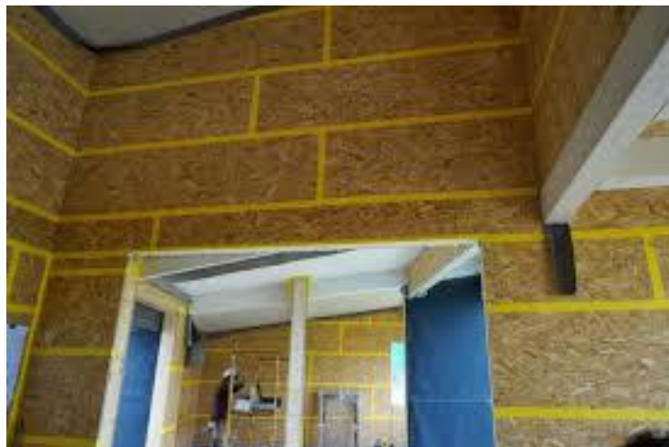
Fotografía 6 Paneles de madera con juntas selladas estancas al aire.
