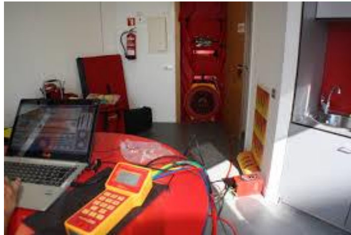
Fotografía 9 Prueba de estanqueidad del Blower Door Test.
