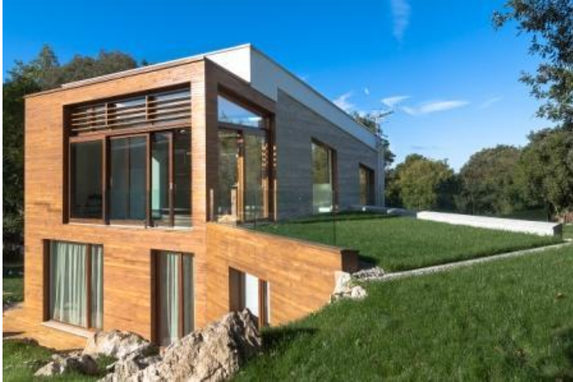
Fotografía 4 Vivienda "Entre encinas" por parte de su cerramiento soterrado.
