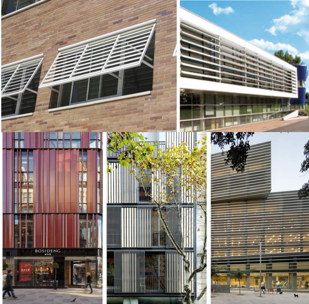
Fotografía 11 Diferentes protecciones solares.
