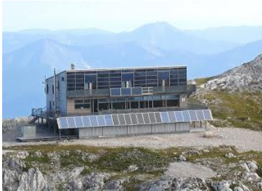
Fotografía 2 Refugio Schiestlhaus, el primero de alta montaña construido según el estándar Passivhaus (Hochschwab, Austria).
