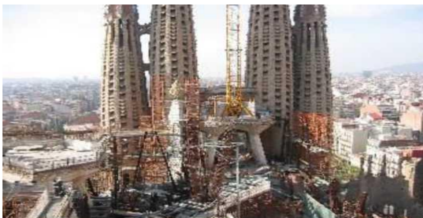
Figura 12. Grúas torre estacionarias en la construcción de la Sagrada Familia, Barcelona.
