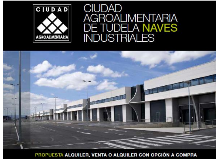
Ilustración 1. Exterior de nave industrial.
