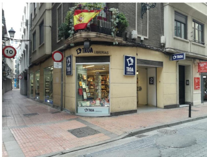
Figura 9: Fachada de la librería. Fuente: Fotografía realizada por Cristina Sáenz.
