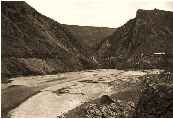
FIGURA 4 VISTA DE LAS OBRAS EN EL ENTREMÓN, DESDE MEDIANO. 1930/35
