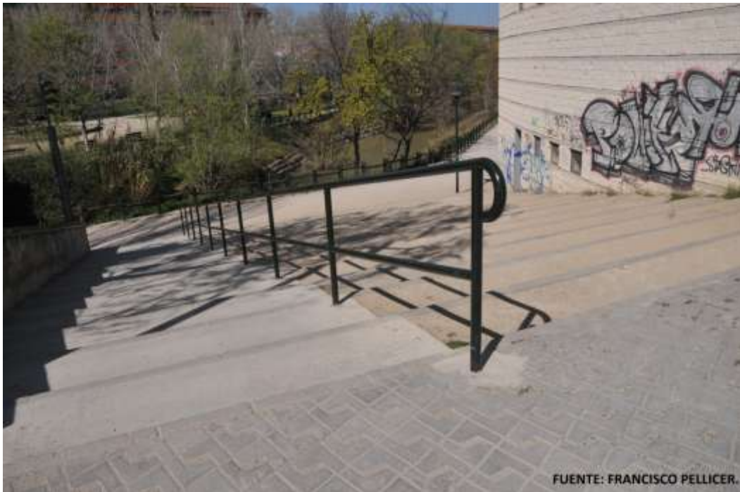
Ilustración 77 (Acceso al Parque Bruil sin rampa).
