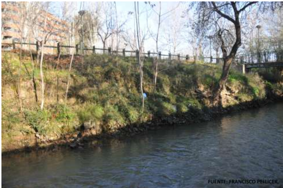
Ilustración 30 (Antigo estado del cauce del Huerva, escarpe y vallado).
