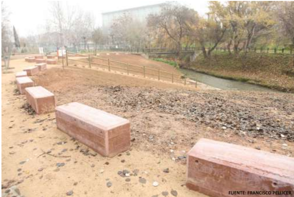
Ilustración 32 (Bancos, rampa y escaleras de acceso a la lamina del río Huerva).
