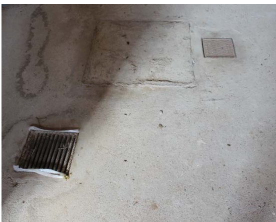
Ilustración 11: Instalación de saneamiento
