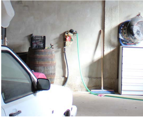
Ilustración 12: Instalación de fontanería
