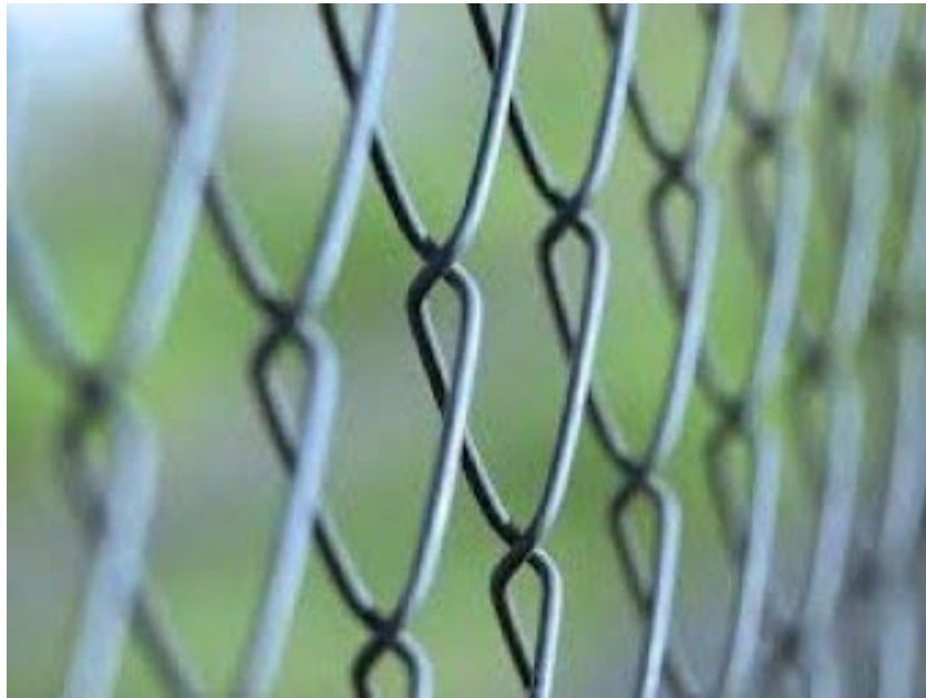
Ilustración 1: Malla galvanizada de simple torsión.
