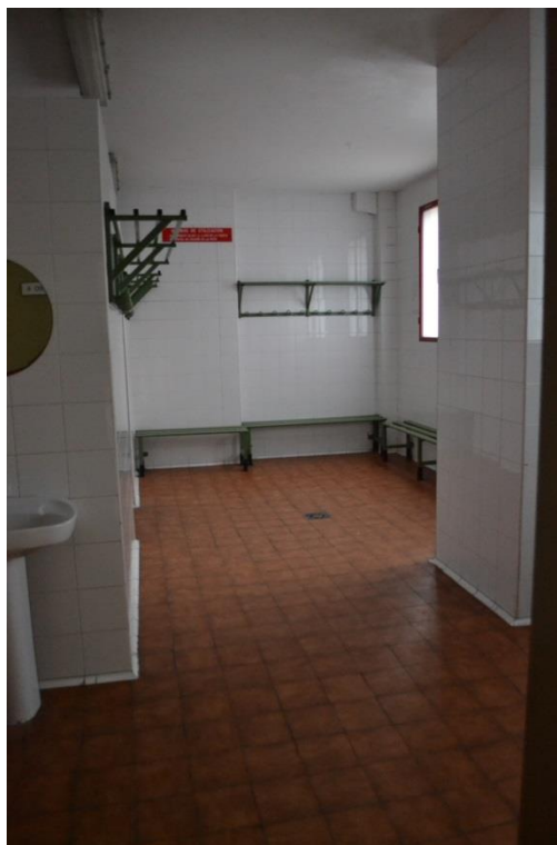
—Foto 8: Vestuario a reformar por la instalación de ascensor —
