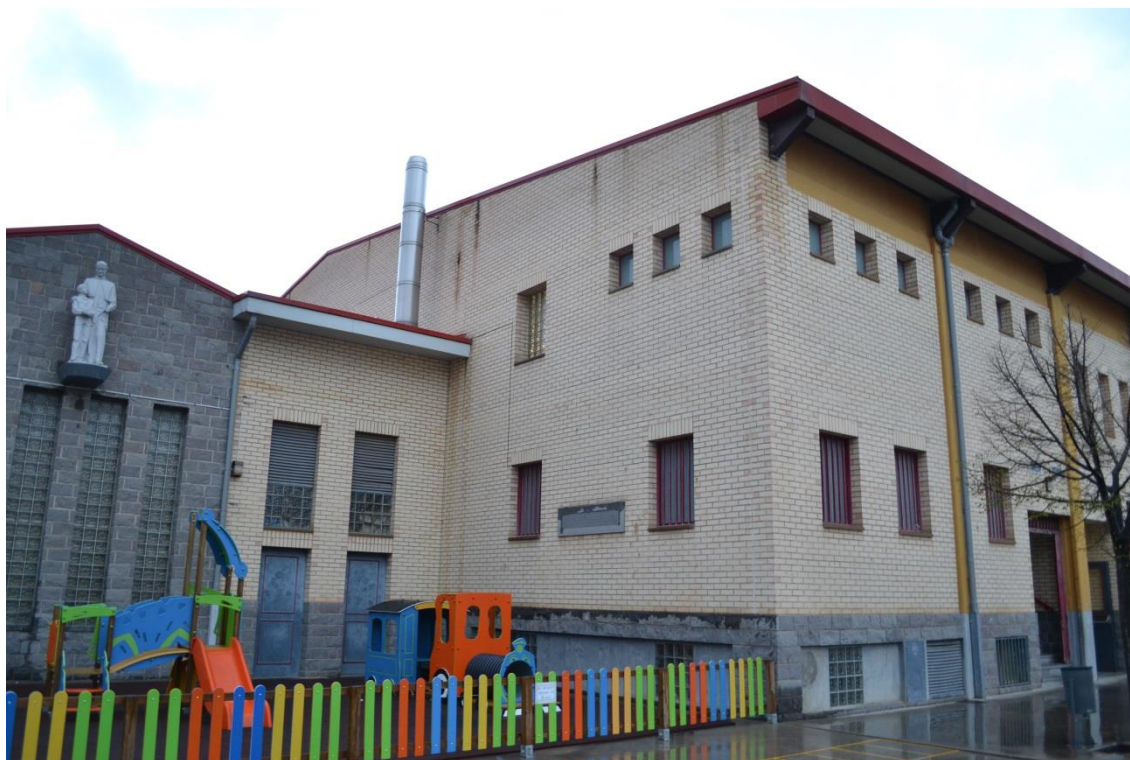
—Foto 3: Alzado lateral patio de colegio —
