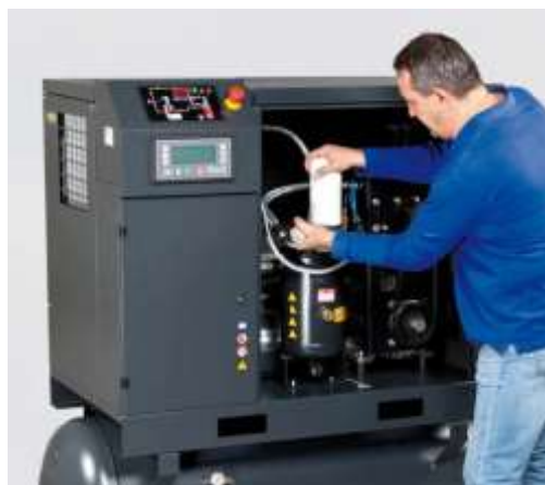
Ilustración 5: Sustitución filtro (mantto. preventivo).
