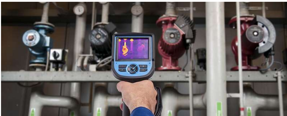
Ilustración 4: Estudio termográfico (mantto. predictivo.).
