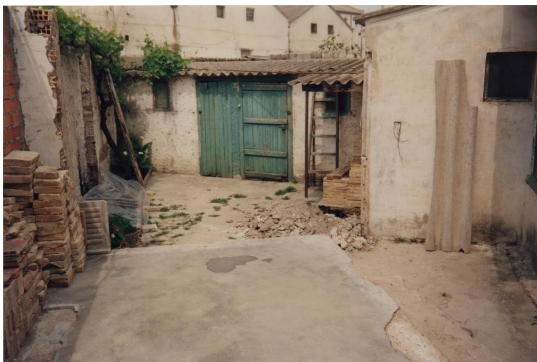
Ilustración 7: Cuadra y cobertizo
