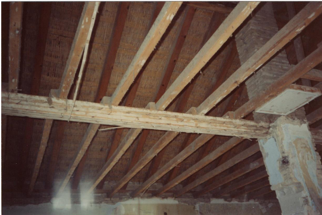
Ilustración 9: Estructura de viguetas de cielo raso
