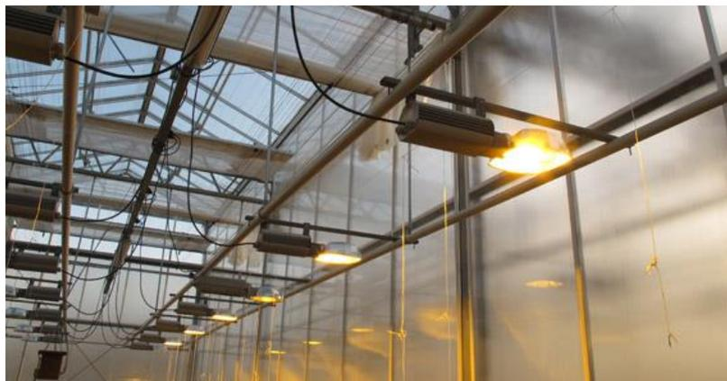
*Ilustración 43. Lámpara de alta presión de sodio.*
