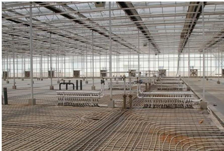
*Ilustración 39. Tubos de calefacción bajo suelo.*
