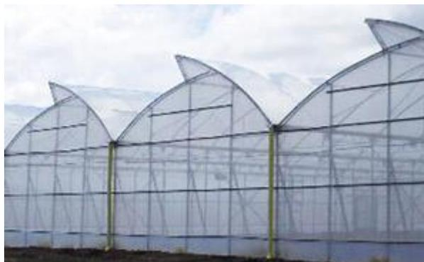
*Ilustración 16. Invernadero tipo Asimétrico o Inacral.*
