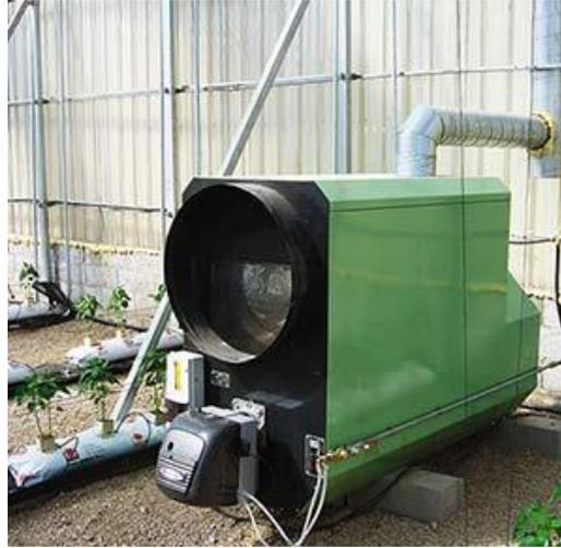
*Ilustración 37. Generador de aire caliente*
