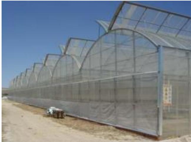
*Ilustración 25. Invernadero con ventilación natural.*
