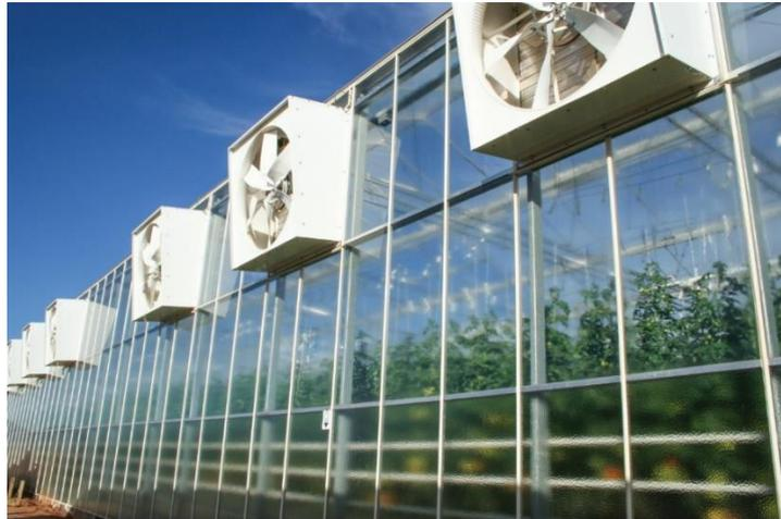
*Ilustración 26. Ventilación forzada.*
