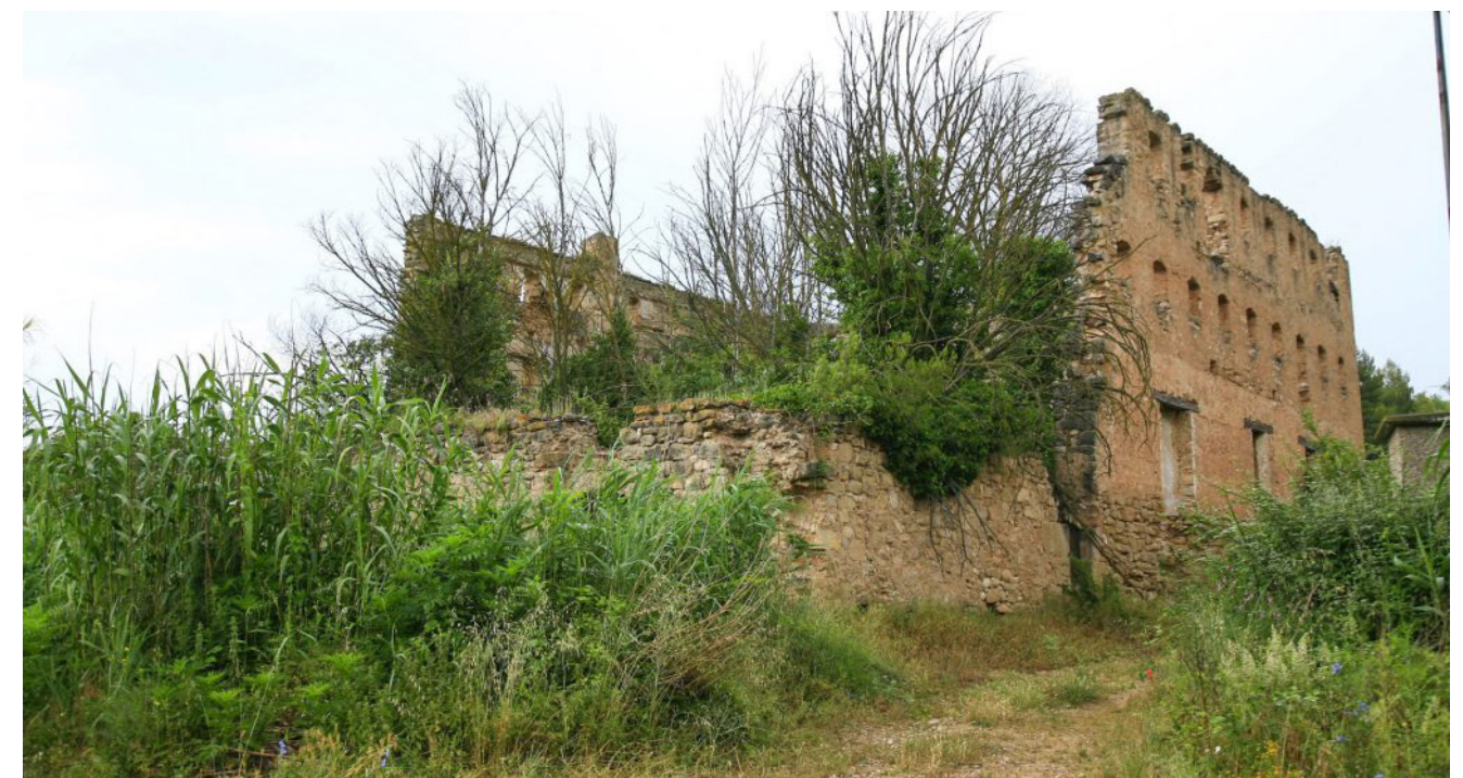
Fig 3.58: Fotografía actual de la fachada derrumbada
