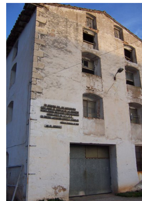
Fig 3.40: Fotografía actual de la situación de la Fábrica del Batán
