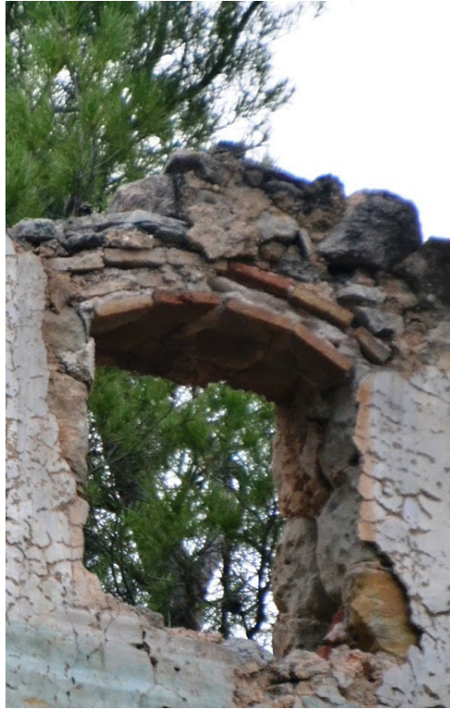
Fig 3.65: Detalle de la construcción de las ventanas para el secado en las plantas superiores
