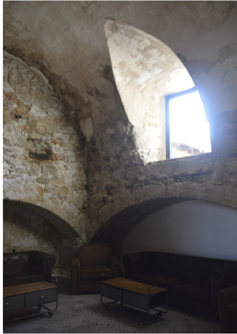
Fig 3.52: Fotografía actual del interior de una de las salas con las características ventanas
