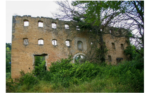
Fig 3.89 Imagen actual de la fachada principal de la fábrica
