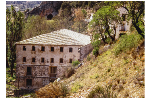
Fig 3.45: Vista exterior actual de la Fábrica del Pont Nou
