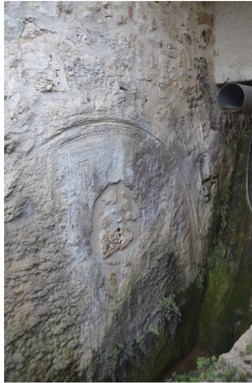
Fig 3.34: Espacio en el que se encontraba la antigua rueda de agua y marcas en la pared hechas por esta
