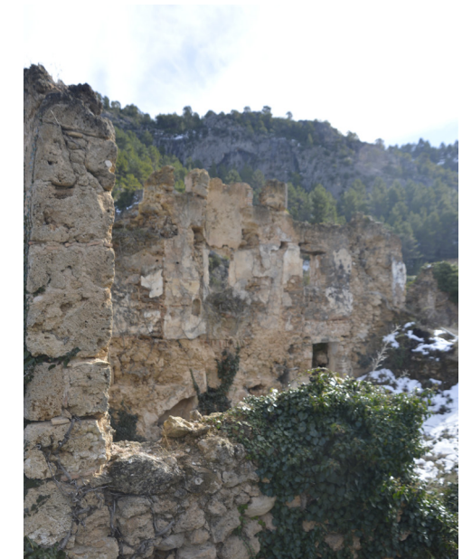
Fig 3.3: Vista del interior de la Fábrica Martín Fon
