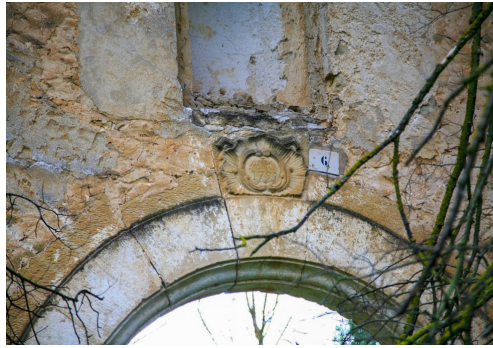
Fig 3.59: Detalle del arco de entrada con la fecha de construcción sobre este
