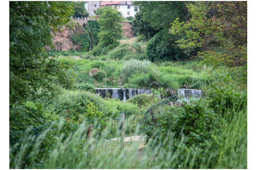
Fig 3.81 Azud de la fábrica del Batán en la población de Beceite
