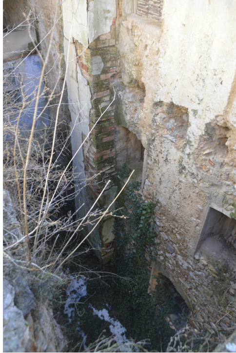
Fig 3.46: Paso del agua a través de la Fábrica del Pont Nou
