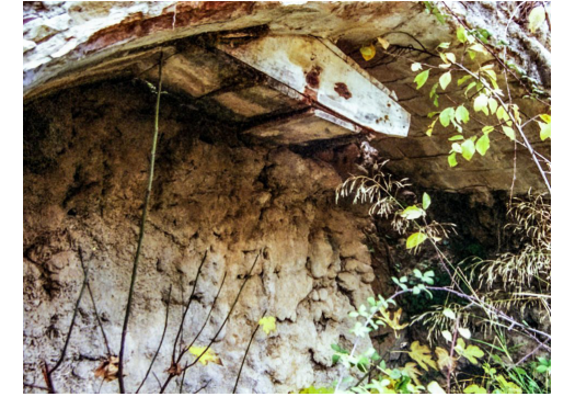
Fig 3.77 Entrada del agua a rueda hidráulica situada en el interior de la fábrica
