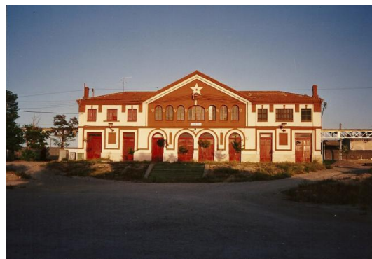
Ilustración 16: Fachada estación de tren de Zuera. Extraído de: (Charo, 2012)
