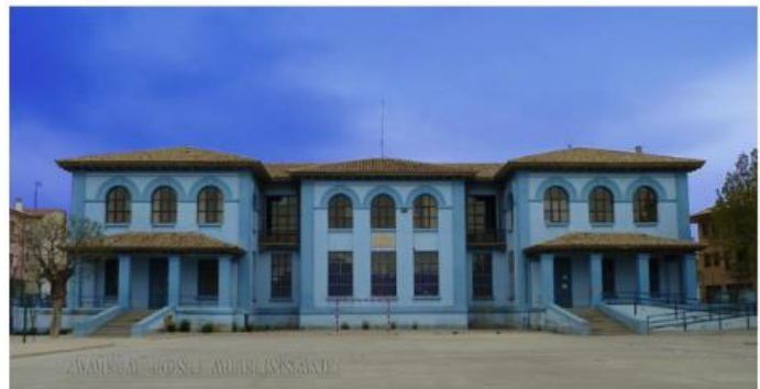
Ilustración 19: Edificio Odón de Buen en Zuera. Extraído de: (Aurensanz, 2023)
