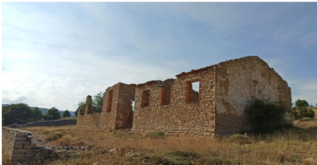
Imagen 31. Estado actual de la escuela masovera de Los Carrascales (Mosqueruela).
