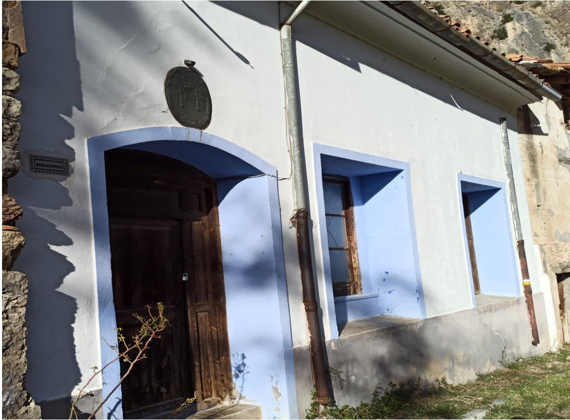
Imagen 45. Fachada de la escuela de Las Fábricas en el término municipal de Villarluengo.
