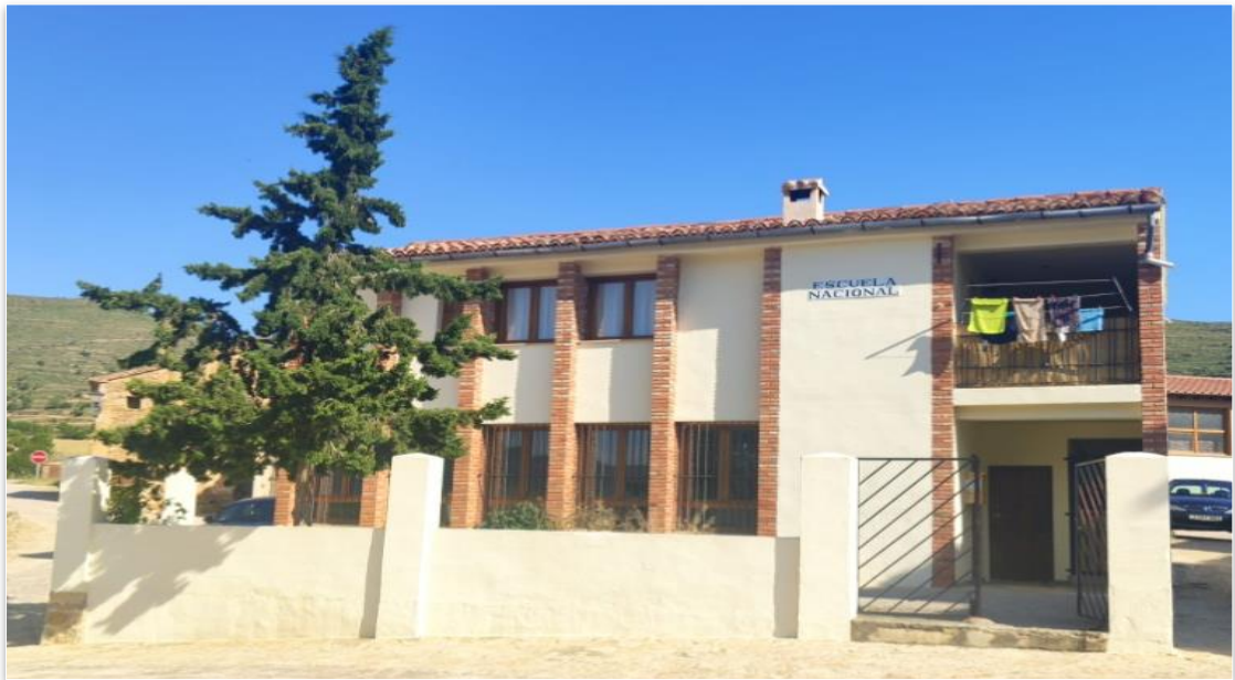
Imagen 59. Escuela de Cañada de Benatanduz, actualmente habilitada como multiservicio. Imagen 60. Escuela de Mirambel con vivienda para maestro en la primera planta.
