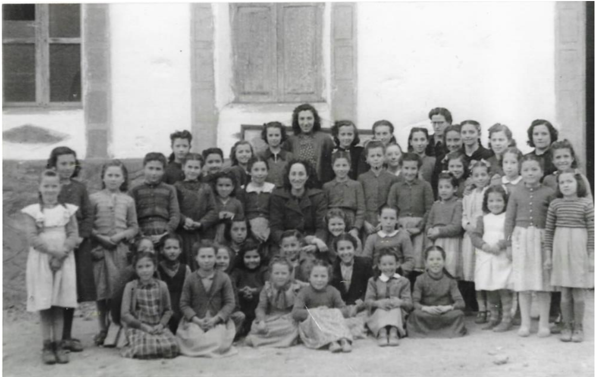
Imagen 13. Estado actual de la escuela de Mosqueruela. Imagen 14. Alumnas de la Escuela Nacional de Niñas de Mosqueruela, año 1950. Al fondo la fachada de la escuela construida en 1923. Foto propiedad de Trinidad Monforte.
