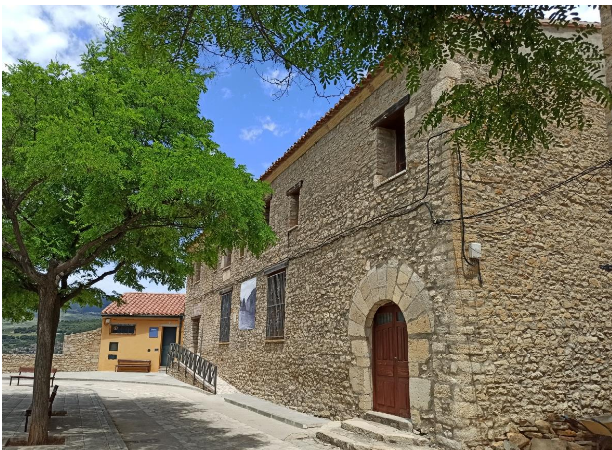
Imagen 9. Edificio del Aula de Gramática Latina de Cantavieja.
