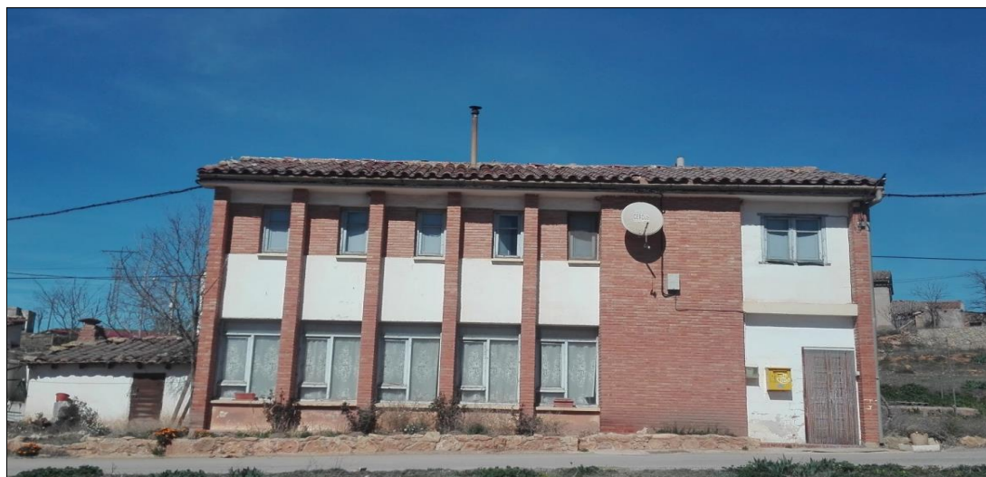
Imagen 57. Recinto escolar de la Iglesuela del Cid con tres viviendas para maestros y una escuela. Imagen 58. Escuela del barrio de La Escaleruela en Sarrión, con vivienda para maestro en la primera planta.
