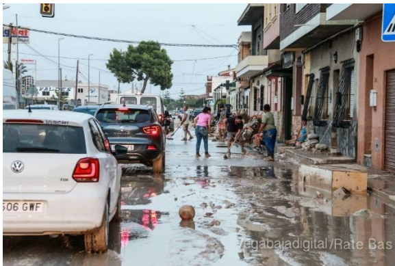
Figura 5.33. Efectos del desastre en la Vega Baja tras el paso de la DANA de 2019. (10)
