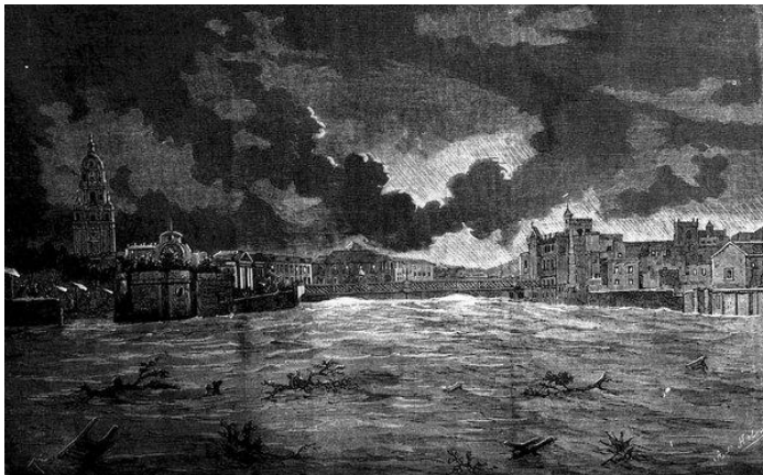
Figura 5.10. Grabado de Gustave Doré de la riada de 1879 a su paso por Murcia. (8)
