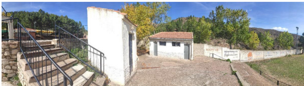
Casetas material y vestuarios. EA_Nivel 2.
