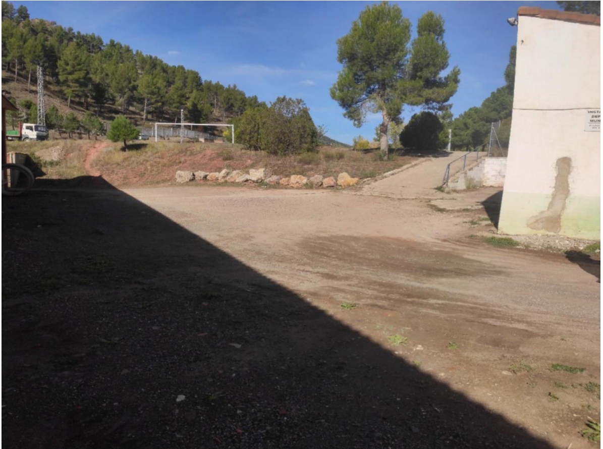
Pavimentación. Entrada calle Balmes. EA_Nivel 0.
