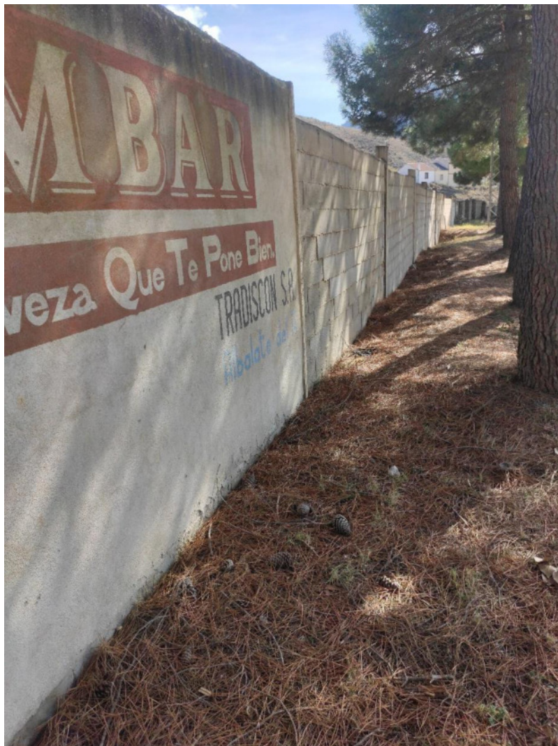
Muro cerramiento interior parcela. EA_Nivel 1.
