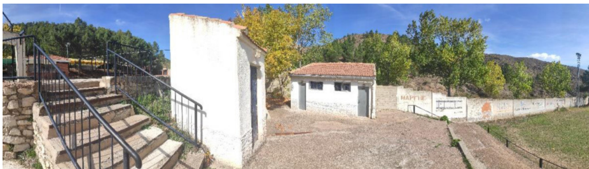
Casetas material y vestuarios. EA_Nivel 2.
