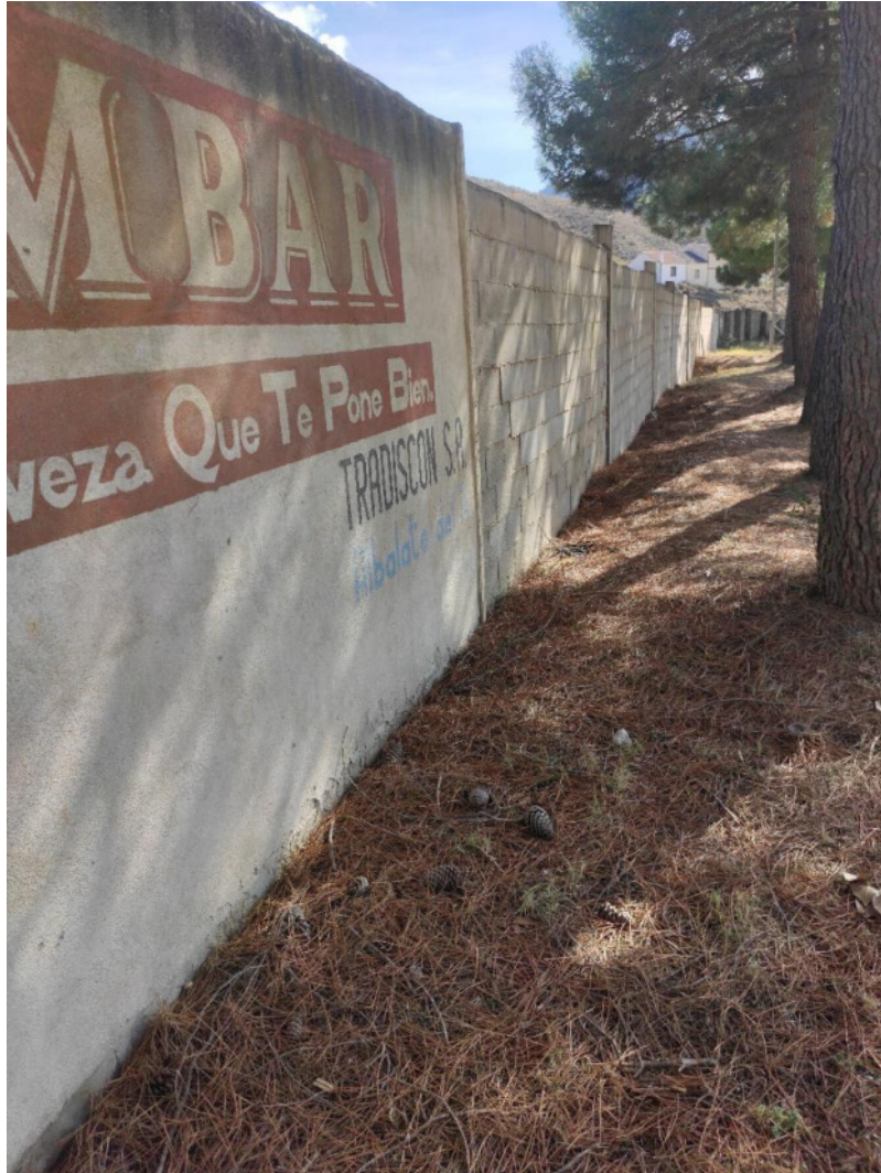
Muro cerramiento interior parcela. EA_Nivel 1.
