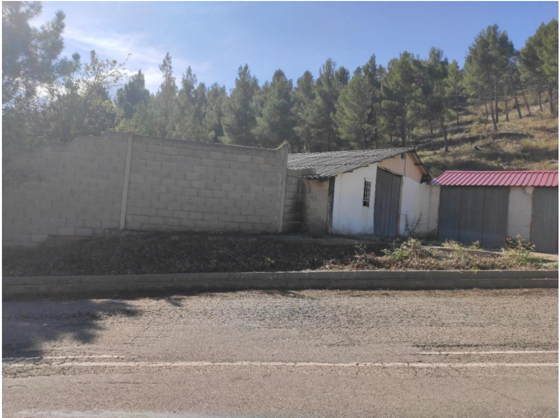
Muro cerramiento exterior parcela. Entrada calle Toril. EA_Nivel 4.
