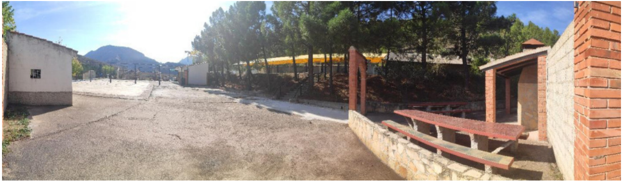
Pavimentación. EA. Nivel 3.
