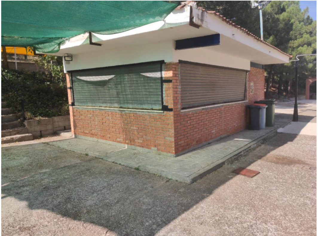
Caseta bar. EA_Nivel 3.
