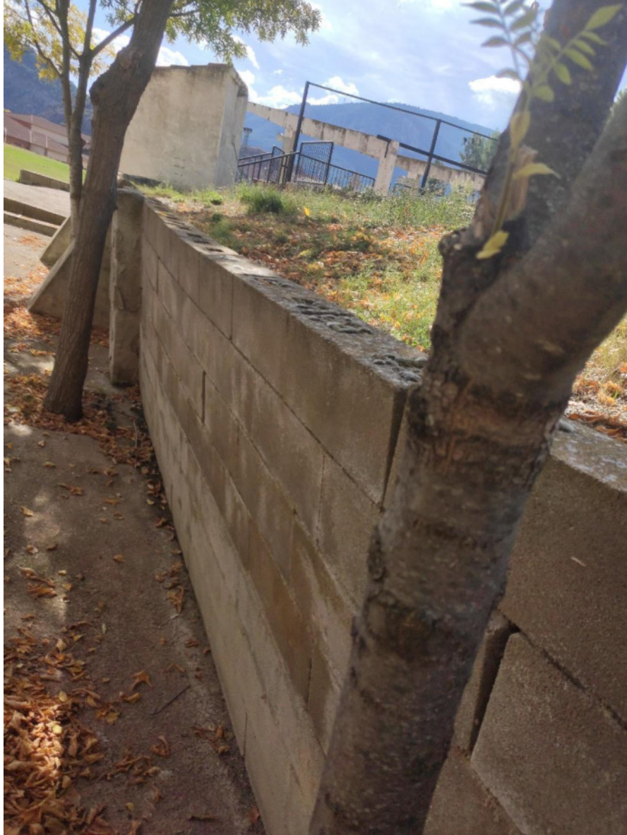
Murete de contención. EA_Nivel 2.
