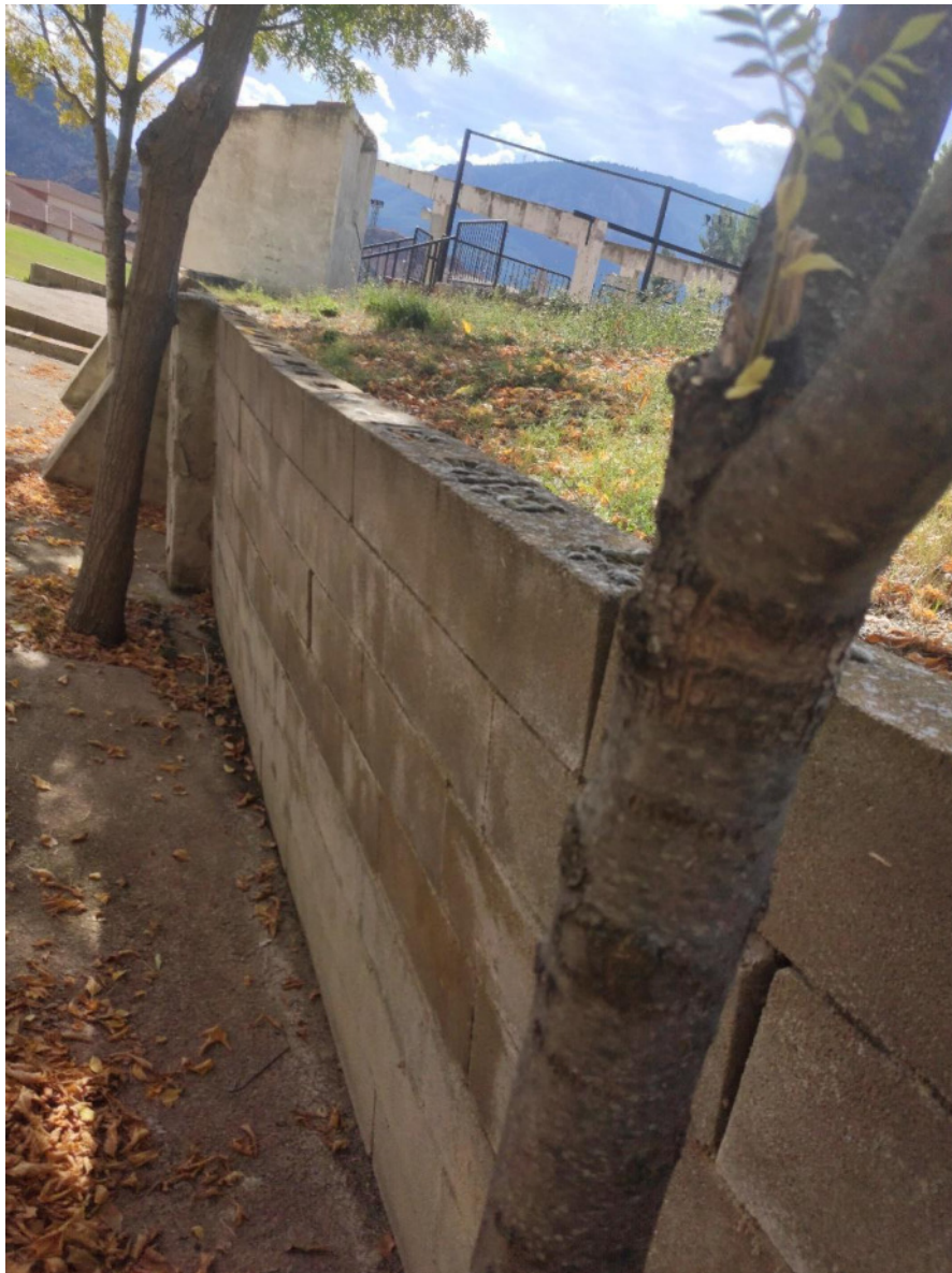
Murete de contención. EA_Nivel 2.
