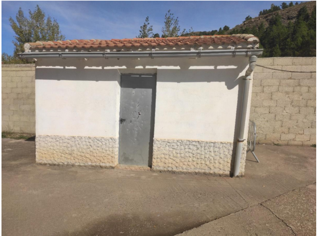
Caseta material. EA_Nivel 3.
