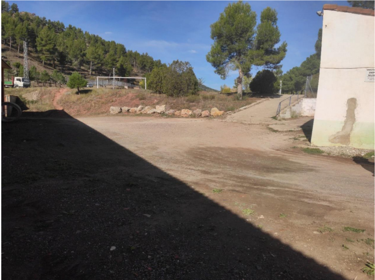
Pavimentación. Entrada calle Balmes. EA_Nivel 0.
