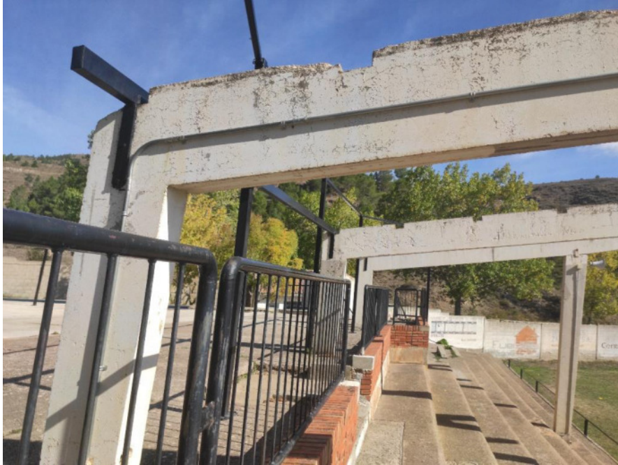
Soportes de la cubierta del graderío. EA_Nivel 3.
