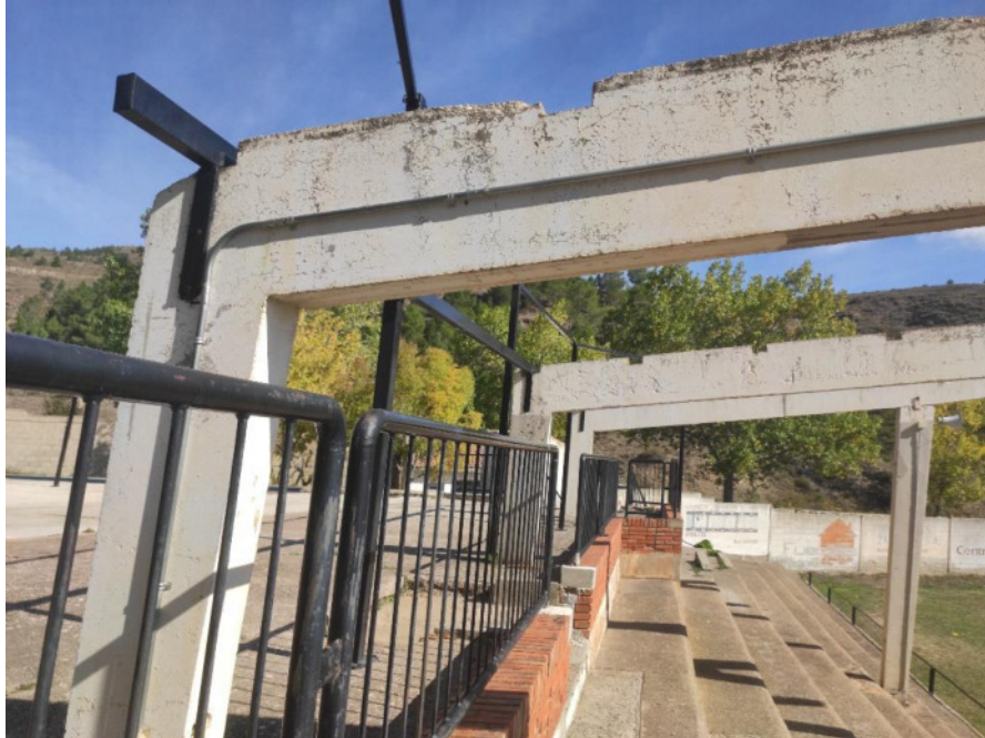
Soportes de la cubierta del graderío. EA_Nivel 3.
