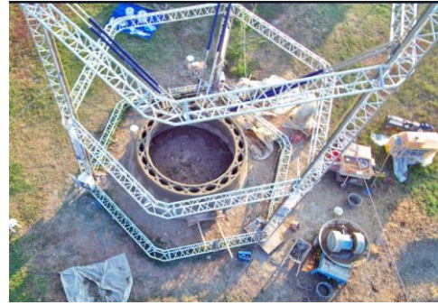
Figura 1.5.5. Construcción de vivienda 5
