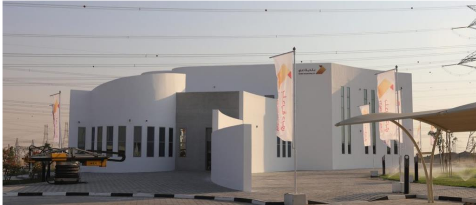
Figura 1.5.13. Estructura final de la vivienda en Dubái. 13
