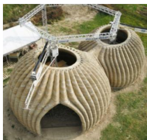
Figura 2.13. Vivienda de adobe por WASP en Italia. 25
