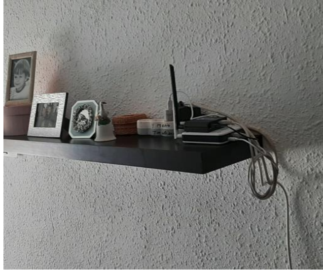
Figura 16. Router y Gateway en piso P2 (3º-3ª)
