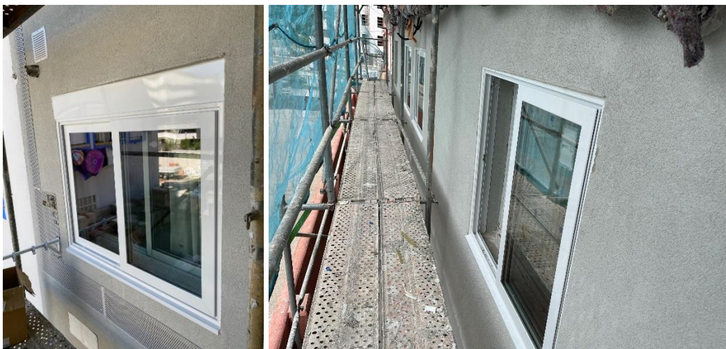
Figura 7. Colocación de doubles ventanas
