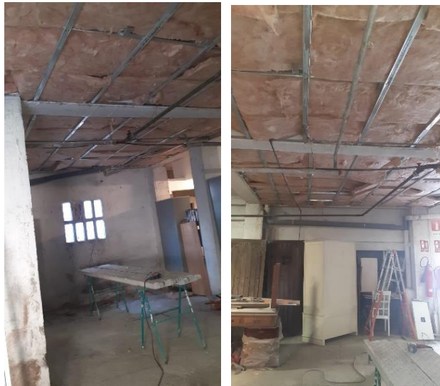
Figura 6. Colocación de lana mineral en techo local
