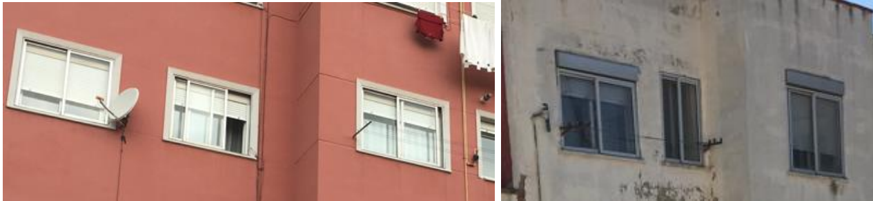
Fig. 34 Detalle ventanas fachadas principales y traseras
