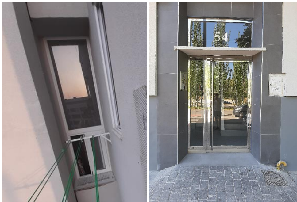
Figura 8. Vista exterior ventana hueco escaleras y puerta de entrada al edificio
