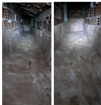
Figura 5. Colocación de lana mineral entre tabiquillos palomeros
