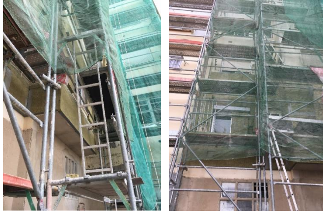
Figura 3. Colocación de paneles de lana de roca en fachadas
