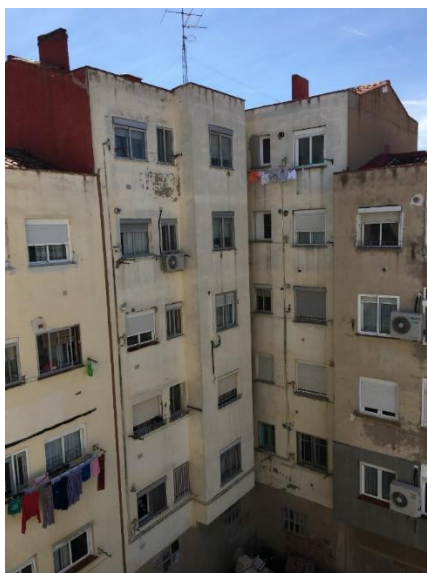
Figura 4. Fachada trasera en patio interior antes de rehabilitación
