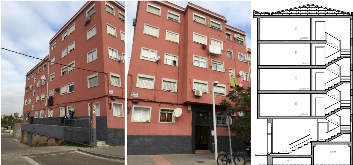
Figura 2 . Edificio Avda. Manuel Rodríguez Ayuso 54 antes de rehabilitación
